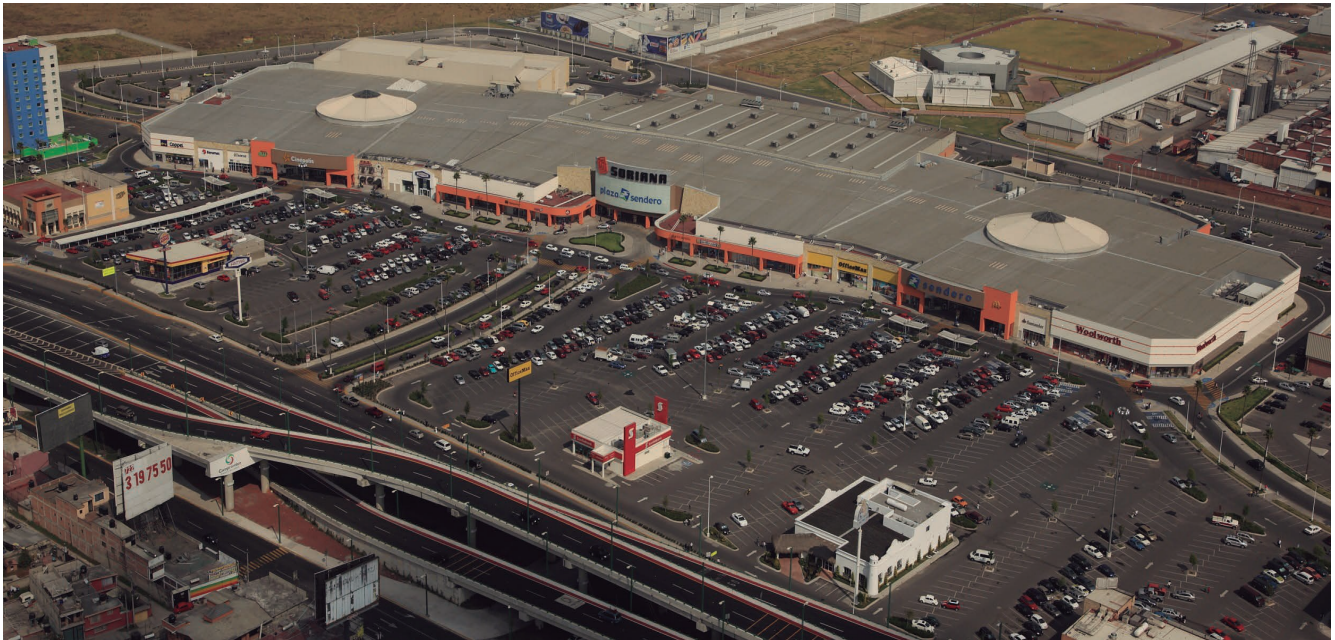
Avenida Abraham Lincoln No. 4001 Col. Puerta de Hierro.
